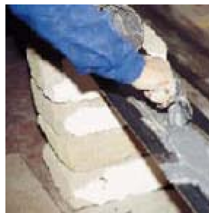
нанесение ADESILEX PG1 на металлическую пластину
