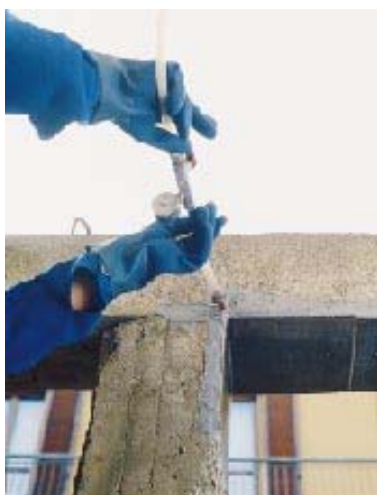
усиление бимса с использованием ADESILEX PG1
