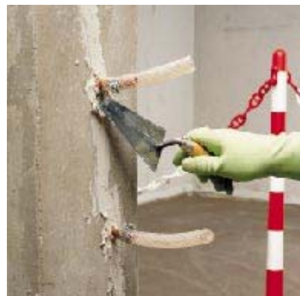
приклеивание патрубков для заделки трещины методом инъекции
