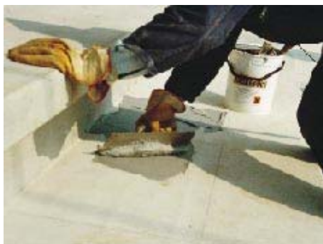
использование зубчатого шпателя для нанесения ADESILEX PG1 для структурной связки на ступенях лестницы
