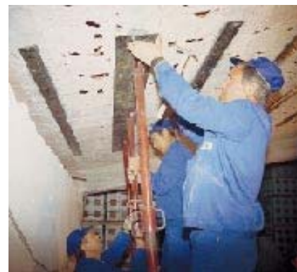
использование металлической пластины для структурного упрочнения
